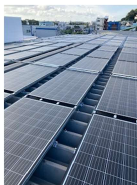
生産技術センター3階屋根
