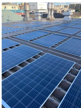
生産技術センター2階屋根
